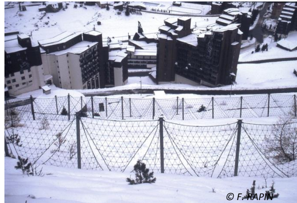
Photo 14 : Filets paravalanches, Avoriaz (74)
